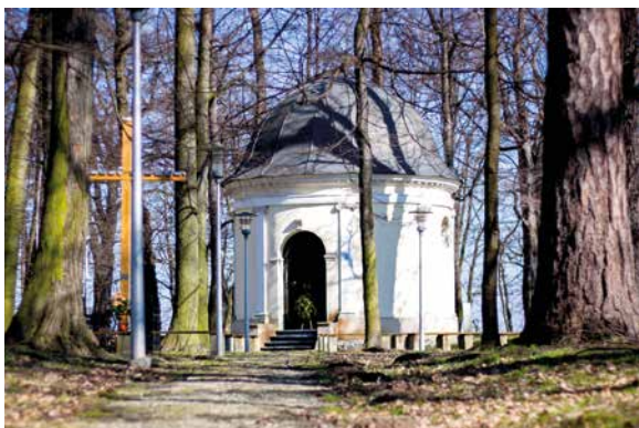
Kaplica Hallerów w Dworach z początku XIX wieku.
